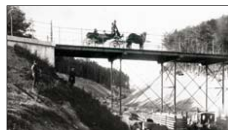
En typisk konstruktion af en skruerpælebro ses på billedet af Ermelundsbroen i 1890 med den udgravede Ermelundsbakke i baggrunden.
